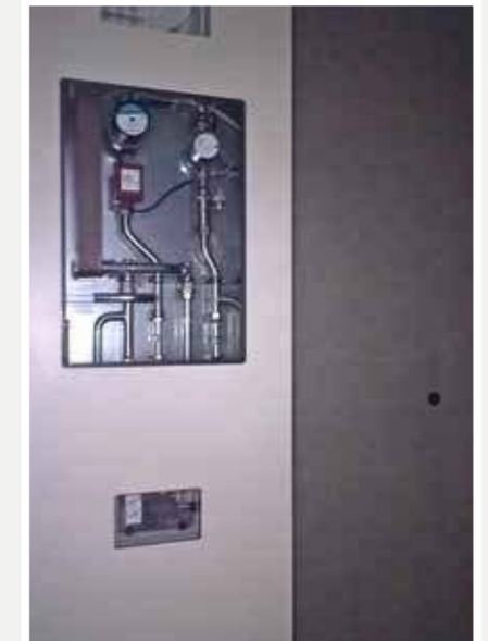
3. Vergießen der offenen Durchbrüche und Einhängen der Wandplatten.
