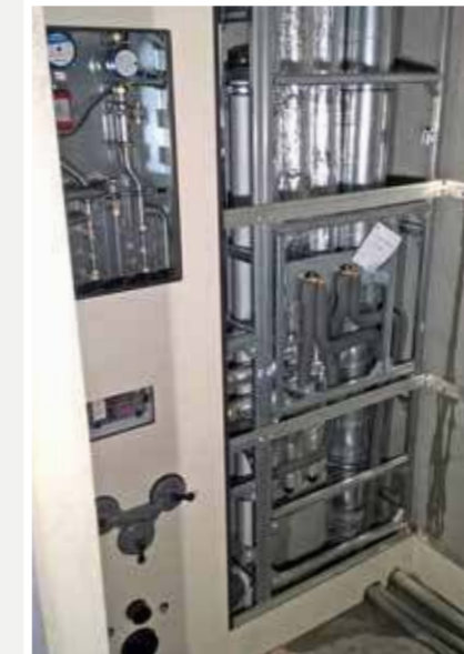
2. Montage von Halteagrippen und Sockelleisten sowie Dichtungen.
