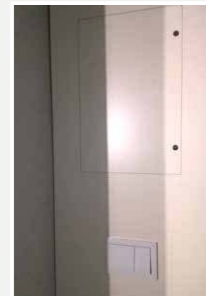
4. Schließen der Revisionsöffnungen. Montage von Bedienelementen.
