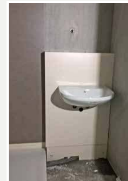
4. Anbringung von Sanitäröbekten, Installation der Duschfläche im Block.
