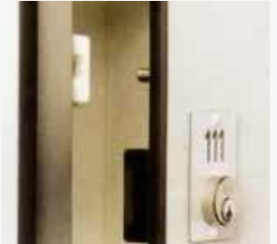
Einbruchssicherung, Abdeckung der Trennwand aus Aluminium, naturfarben eloxiert
