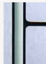
Aluminiumprofilsystem zwischen den Türen, naturfarben eloxiert oder farbig pulverbeschichtet gegen Mehrpreis
