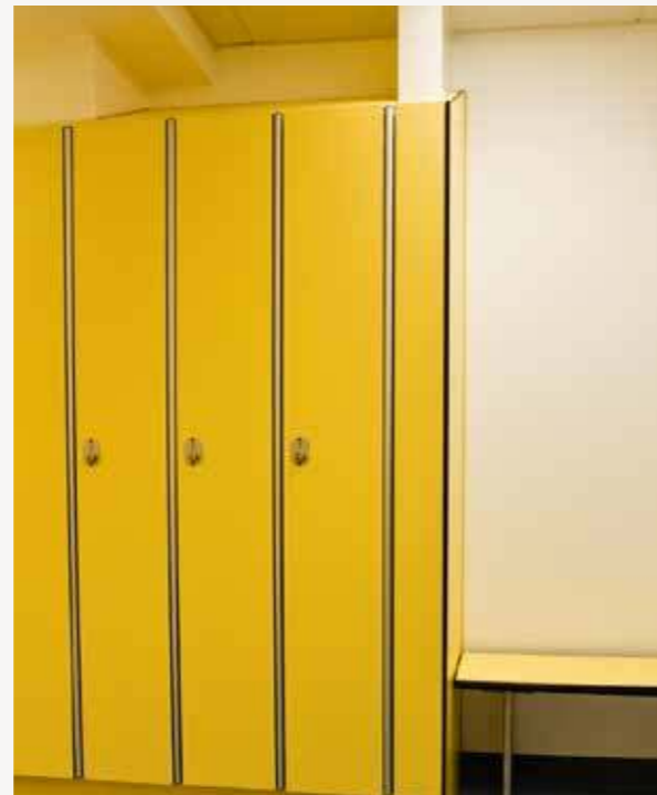
Schränkanlage mit Abluftkanal und Schrägdach als Staubrutsche
