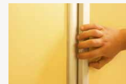
Fingerklemmschutz durch spezielle Gelenke und Gummidichtungen
