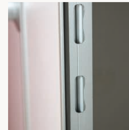
Schließholm - Stanzung für Falle + Riegel
