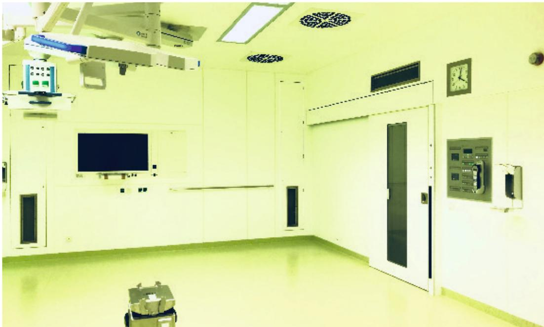
Der Innenausbau von OP- und medizinischen Funktionsräumen erfolgt mit dekorativen Hochdruck-Schichtstoff-Platten (HPL gemäß DIN EN 438) mit dauerhaft antibakteriell wirksamer EBC-Polymeroberfläche als raumhohe Wandpaneel-Verkleidung für Räume mit hohen und sehr hohen Anforderungen an die Keimarmut.
