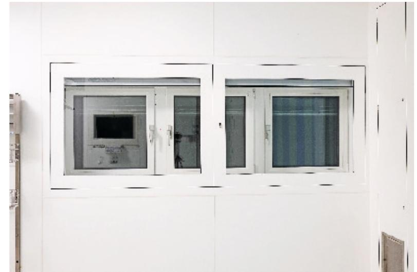
Fassadenfensterfronten können zusätzlich mit Verdunklungsanlagen je nach medizinischen Anforderungen (z.B. minimalinvasive Chirurgie) ausgestattet werden. Hierfür wird für das Wandpaneelsystem eine HPL-Kastenfensterkonstruktion mit bündiger, OP-seitiger Verglasung und im Laibungsbereich eingebautem Elektro-Rollo 230V/AC vorgesehen. Die Kastenfensterkonstruktion gewährleistet die Revisionsierbarkeit des Rollos, Verglasung mit Strahlen- und Laserschutzanforderungen ausführbar.
