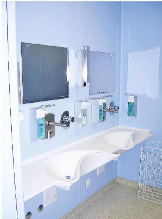
Waschplatzanlagen aus polymergebundenem Mineralwerkstein VARICOR für die chirurgische Händedesinfektion vor der OP. Ausführung als Einzel-, Doppel-, Dreifach- oder auch Mehrfachkombination.
