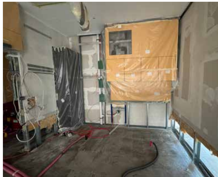
Einleitung OP bei der Demontage
