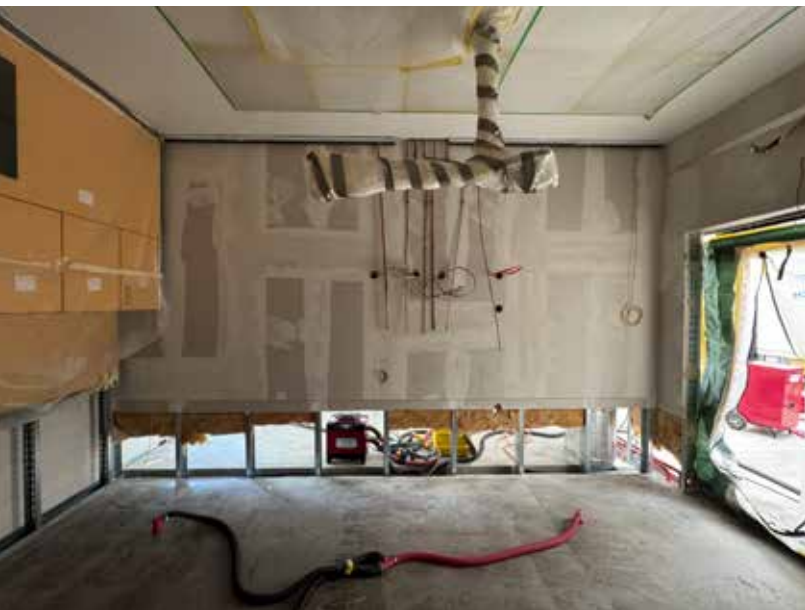
Einleitung OP bei der Demontage
