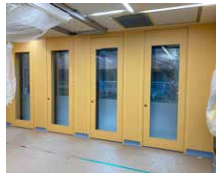
Hybrid OP nach Remontage
