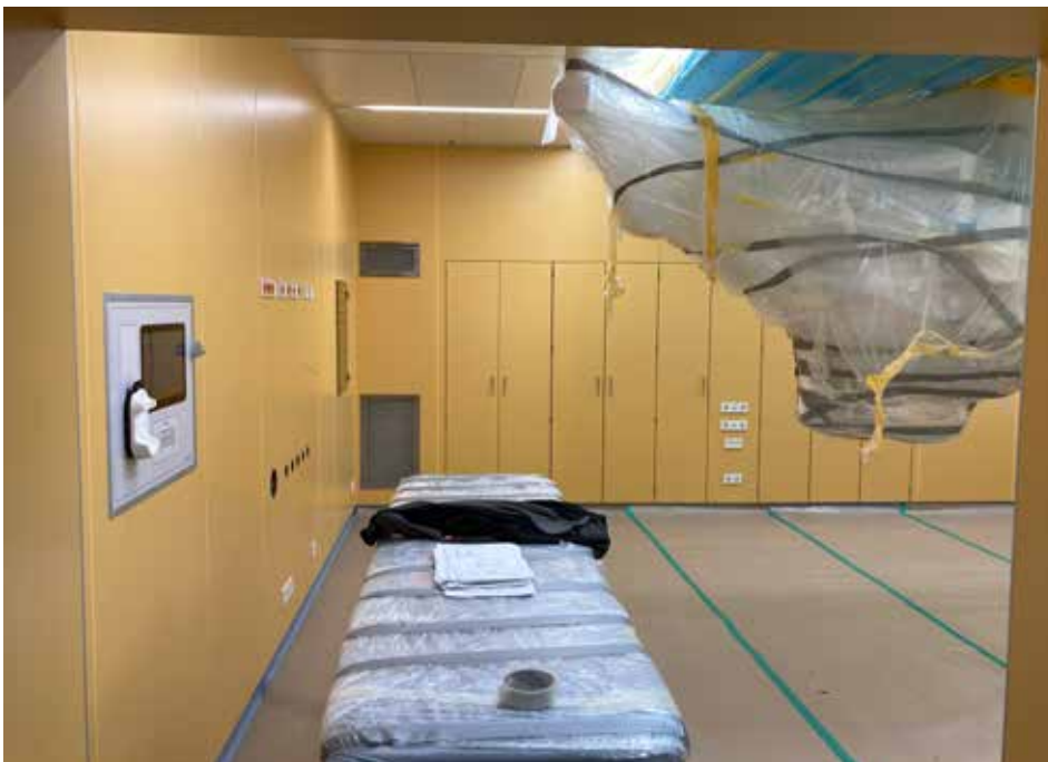
Hybrid OP nach Remontage
