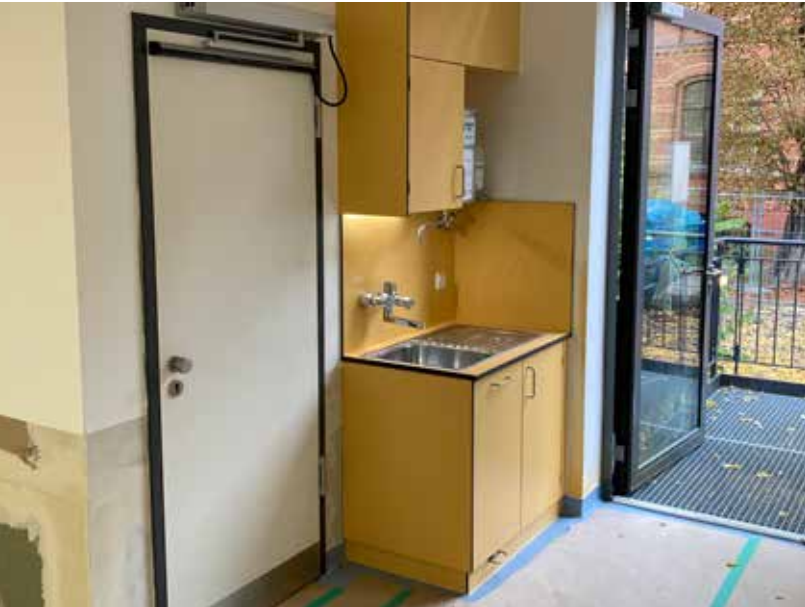
Lafetten Aufbereitung nach der Remontage
